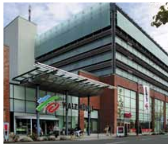
Von links nach rechts: Raumlufttechnische Anlagen des Einkaufszentrums Walzmühle, Außenansicht der Walzmühle.
